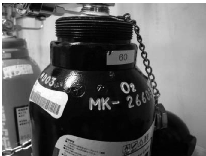
刻印が見やすい位置にボンベを固定する
