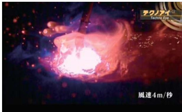
図2 高速度ビデオカメラにより撮影された強風下でのアーク溶接
